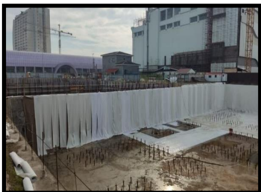
ایزولاسیون و زهکشی گود ساختمان بندر انزلی
