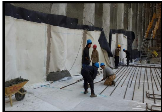
آب بندی گود مجتمع تجاری فرمانیه شرکت بستاب بنا
