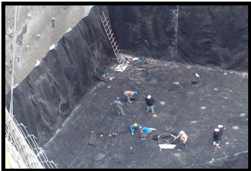
آب بندی گود ساختمانی شرکت کیا بتن
