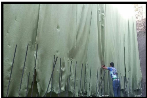
آب بندی گود ساختمانی شرکت کیا بتن
